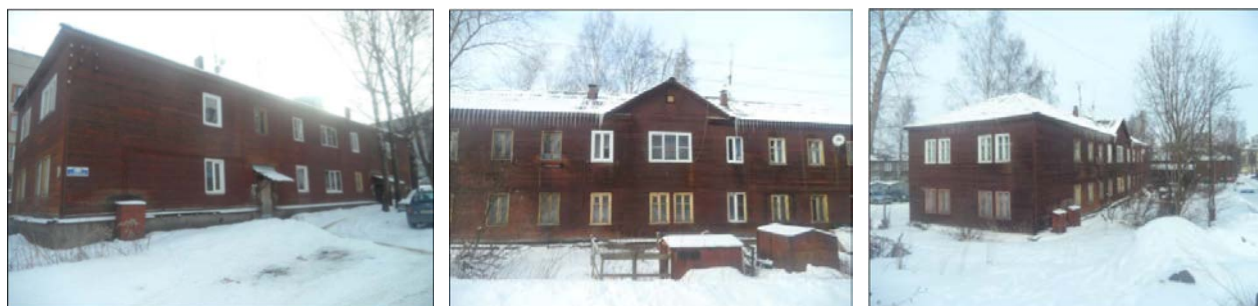
Рисунок 1. Фасады здания до капитального ремонта
