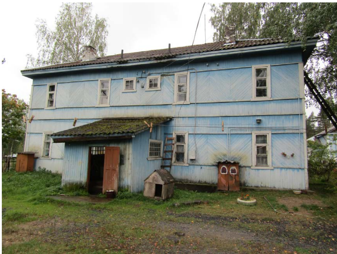
Фото 1. Общий вид фасада здания
