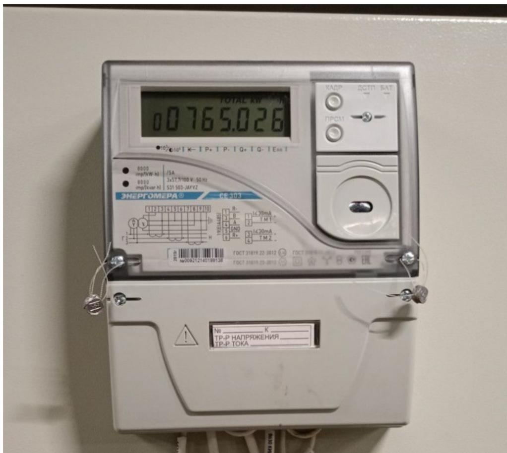
**Фото 2.** Микропроцессорный счётчик электроэнергии ЭНЕРГОМЕРА CE303 S31 [рисунок авторов]
