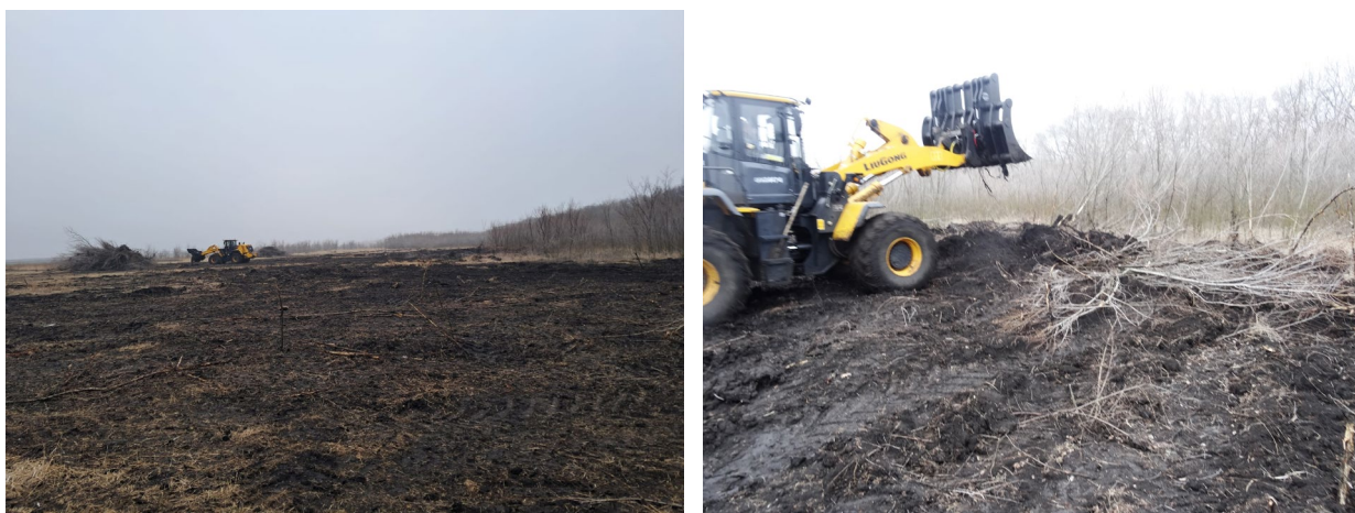
Фото 1. Расчистка полезащитной лесополосы методом выкорчёвывания [фото авторов]
